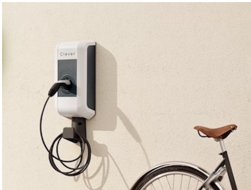
Ladeboksen fra Clever fås færdiginstalleret for under 10.000 kr.
