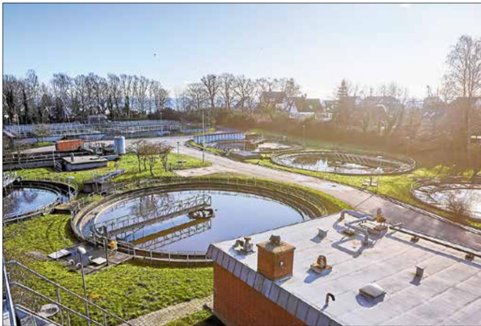
Renoveringen og ombygningen af det ældre og ikke tilstrækkeligt store renseanlæg i Espergærde er ikke det eneste initiativ, som er på vej for at standse de hyppige overløb i særligt i Espergærde.
